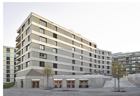
Immeuble d'habitation et de commercial Dübendorf ZH Varmax 450 (439 kW)
