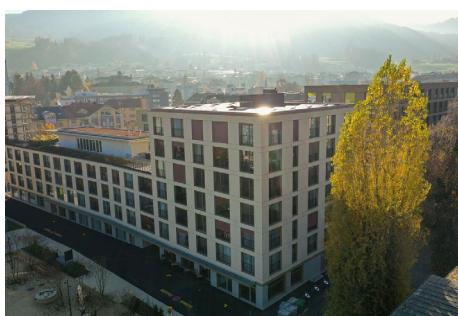
Immeuble d'habitation et de commercial Kriens LU Varmax 225 (219 kW)
