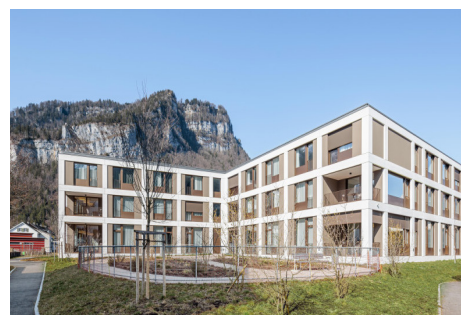
Maison de retraite Näfels GL Varmax 450 (439 kW)
