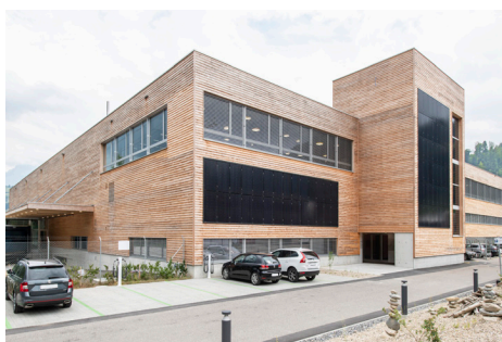
Bâtiment commercial Schachen LU Varino Grande 400 (439 kW)
