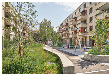
Immeuble d'habitation Berne Varino 200 (195 kW)
