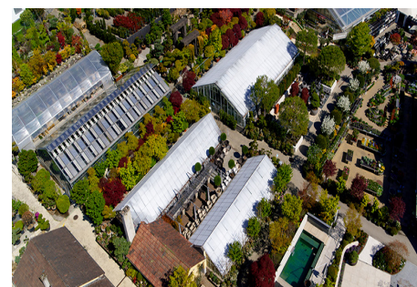
Commerce Unterengstringen ZH Varmax 320 (312 kW)
