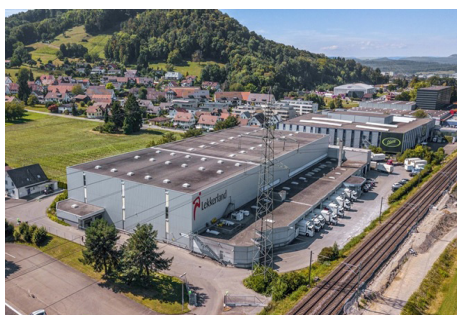
Industriegebäude Brunegg AG LRPK 14 (530 kW)
