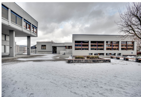
Kantonsschule Beromünster LU LRPK 11 (360 kW)
