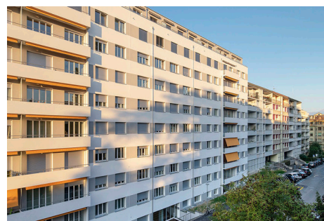
Wohnüberbauung Genf LRPK 14 (530 kW)
