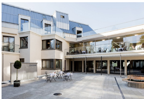
Alters- & Pflegezentrum Zürich LRPK 11 (360 kW)
