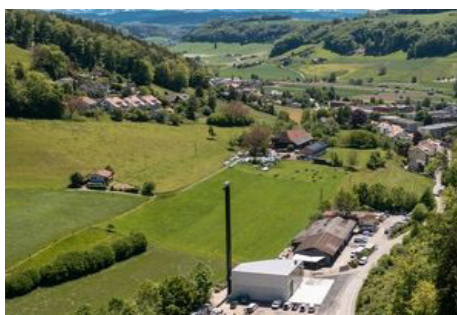
Wärmeverbund Bolligen BE LRR-GF 52 (2'600 kW)
