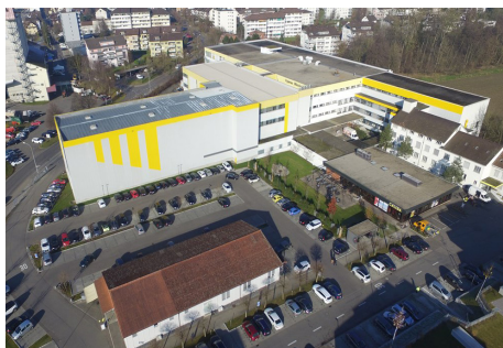
Industriegebäude Sursee LU LRK 26 (850 kW)
