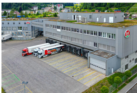
Industriegebäude Zell LU LRR-GF 47 (1'000 kW)
