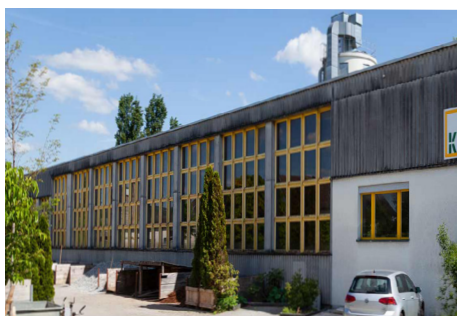
Fabrik Merenschwand AG LRR-GF 47 (1'000 kW)
