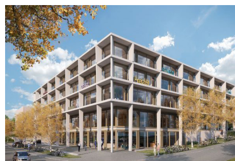
Geschäftshaus Niederwangen BE LRPK 12 (420 kW)
