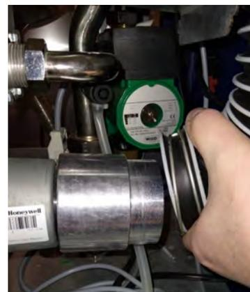
Retirer le flexible d'arrivée d'air
