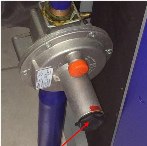
c)-Régler la bonne pression en actionnant la vis de réglage
