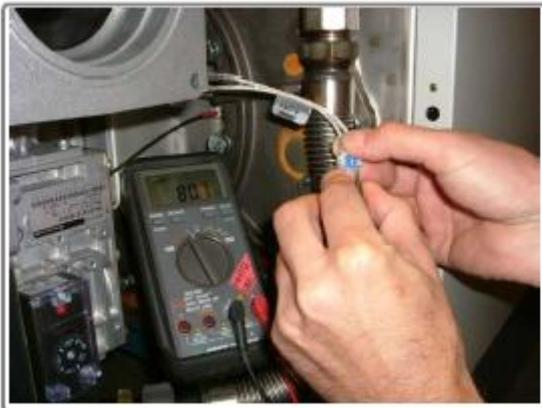
5. Pour un allumage correct de la chaudière, il est recommandé de contrôler la résistance du mécanisme d'allumage. Ce contrôle doit être effectué à froid, à l'aide d'un ohmmètre approprié, en déconnectant le câble de l'allumeur sur le panneau de commande et en mesurant la résistance sur les broches du connecteur mâle. La valeur mesurée doit se situer entre 70 – 200 ohms (voir figure ci-contre).
