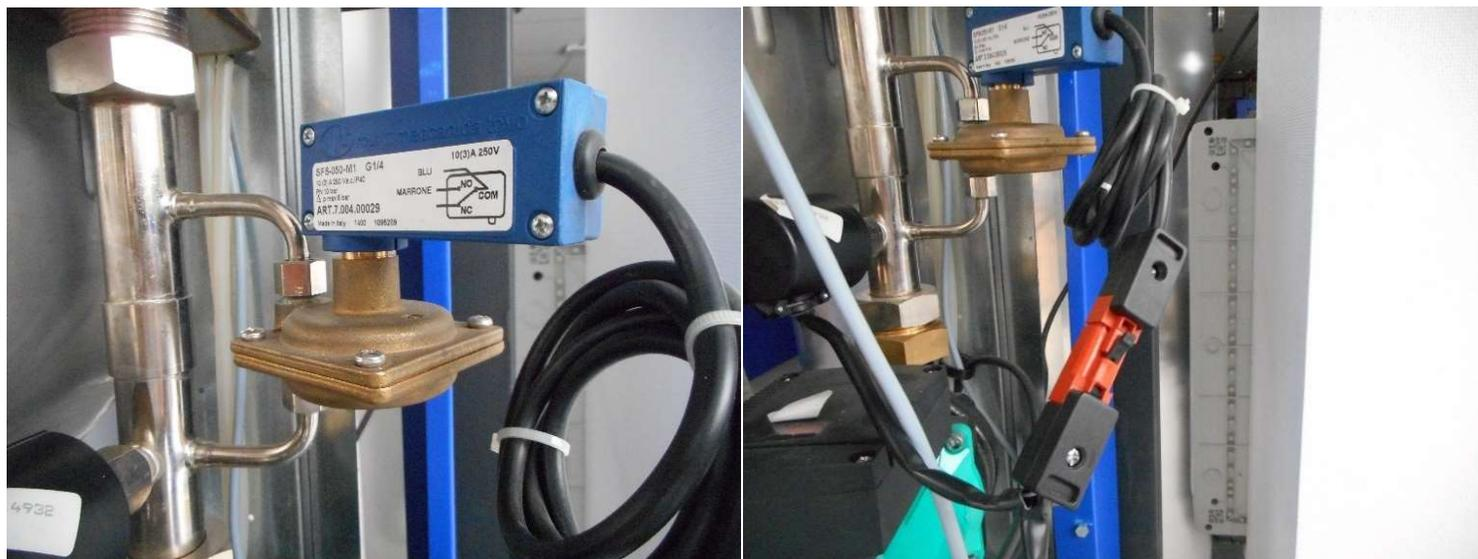
b) shunter le pressostat différentiel
