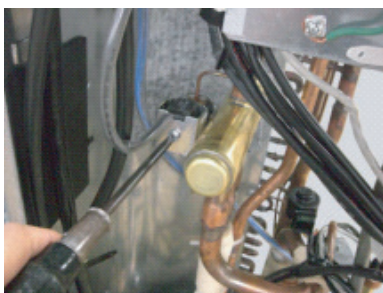
Déposer la vis de montage.
