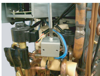
Déposer les vis de montage.
