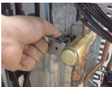
Déposer la BOBINE D'ELECTROVANNE
