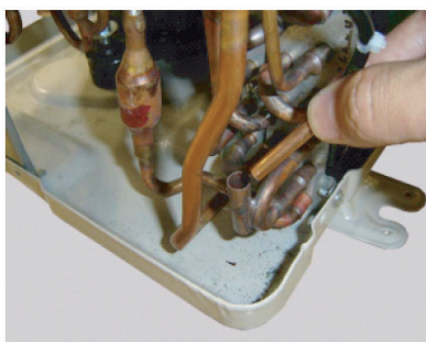
Déposer la THERMISTANCE.
