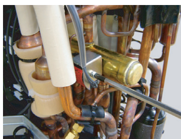
Déposer les vis de montage.
