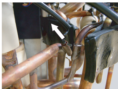
Déposer le ressort de la thermistance.
