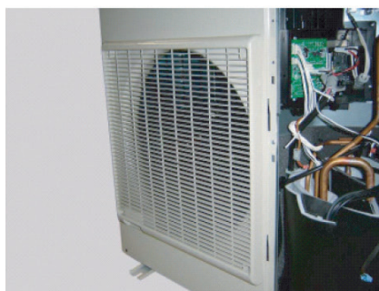
Déposer les 4 vis de montage.
