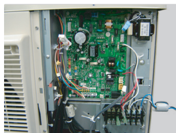
Démonter les connecteurs
