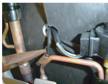
Déposer le RESSORT DE LA THERMISTANCE
