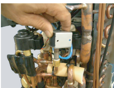
Déposer le capot de vannes.
