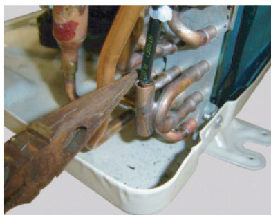
Déposer le RESSORT DE LA THERMISTANCE.
