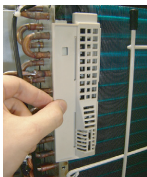
Déposer le support de thermistance.
