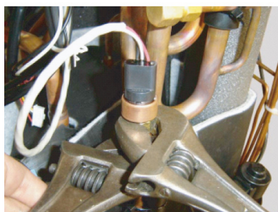
Déposer le CAPTEUR DE PRESSION à l'aide d'une clé.
