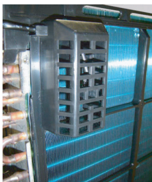
Déposer la GRILLE DE PROTECTION en la faisant pivoter vers la gauche.
