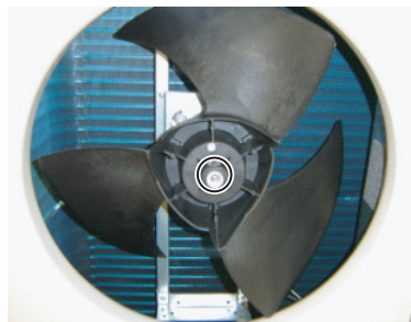
Déposer la vis à tête hex. et déposer l'hélice du ventilateur. Pour la repose, noter ce qui suit . Insérer l'hélice et l'arbre moteur à la position de référence D. Et le couple de serrage à la repose. Il doit être compris entre 10 et 15Nm.
