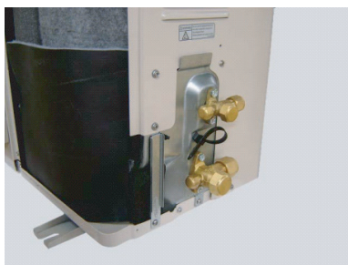
Déposer le capot de vannes
