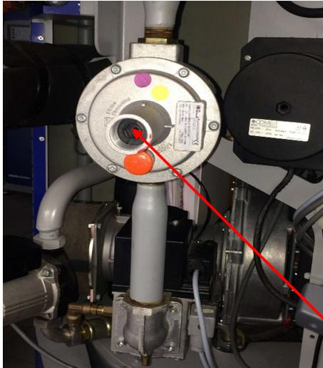
c)-Régler la bonne pression en actionnant la vis de réglage
